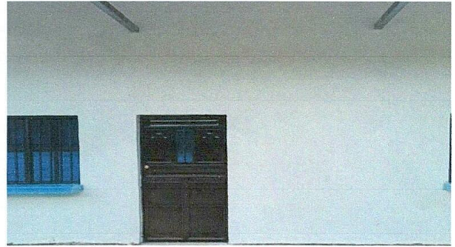
Foto 2: Instalación de Puertas nuevas.
