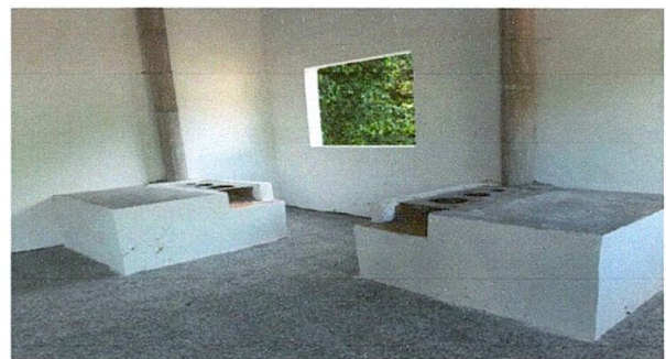
Foto 6: Planchas nuevas instaladas
