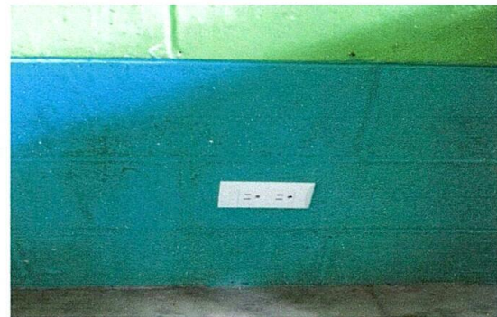
Foto 4: Nuevos tomacorrientes instalados.
