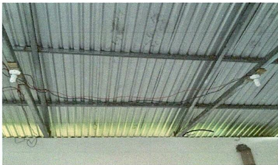
Foto 5: Instalación de cableado eléctrico y focos ahorradores.
