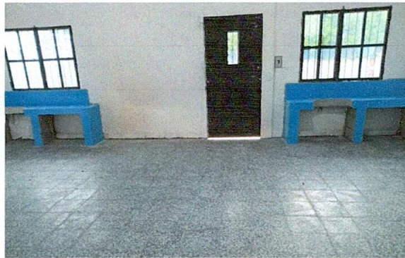
Foto 3: Instalación de dos mesas servidoras de alimentos.
