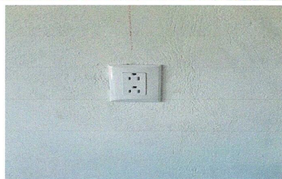
Foto 4: Instalación de nuevos tomacorrientes
