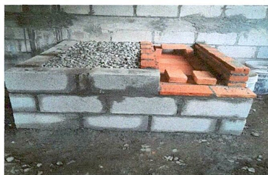
Foto 6: Instalación de Plancha en proceso
