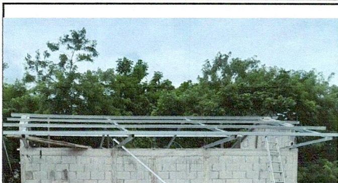
Foto1: Cambio de techo
