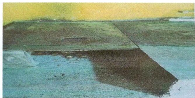
Foto 6: Sustitución de Plancha
