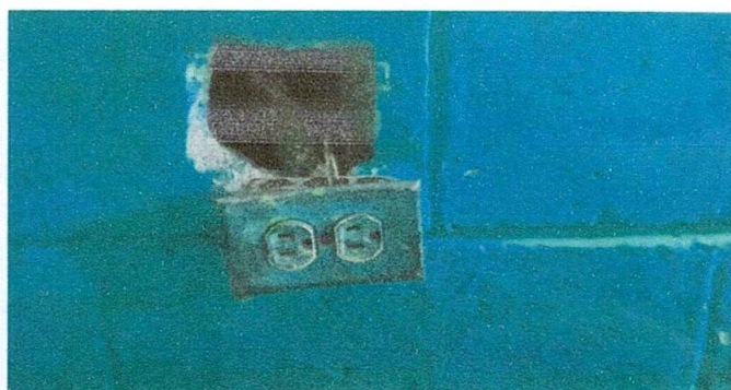
Foto 4: Sustitución de tomacorrientes
