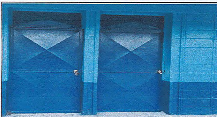
Foto 3: Puertas de las aulas
