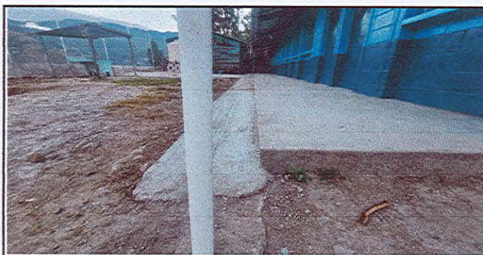
Foto 5: Cunetas de concreto
