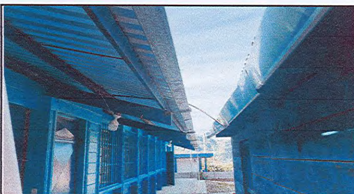
Foto 4: Bajada de agua
