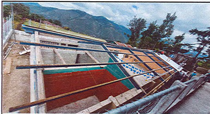
Foto1: Techo de la escuela
