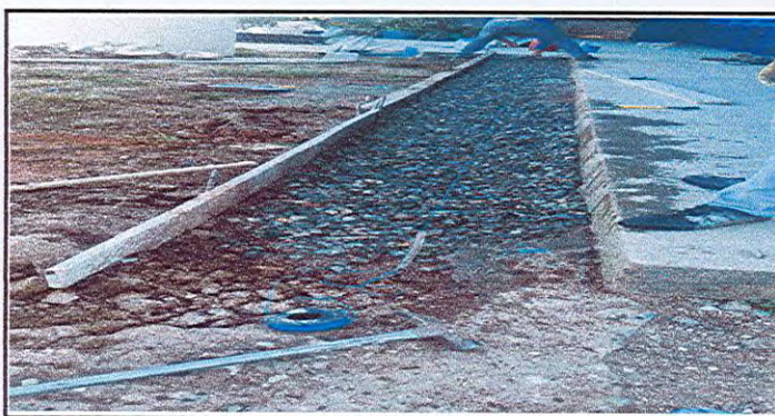
Foto 5: Cunetas de concreto
