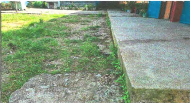
Foto 5: Cunetas de concreto
