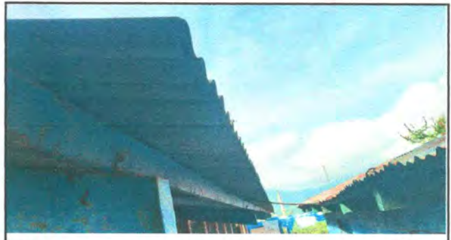
Foto 4: Bajada de agua
