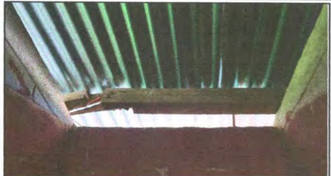
Foto 2: Soporte de madera del baño
