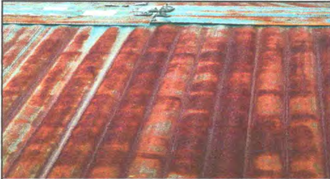
Foto 1: Techo de la escuela
