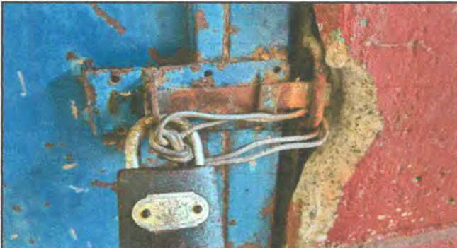
Foto 3: Puertas de las aulas
