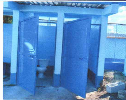
Foto 2: Puertas de sanitarios instaladas
