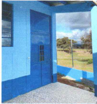
Foto 1: Puertas de aulas instaladas
