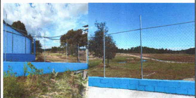
Foto 6: Muro perimetral finalizado
