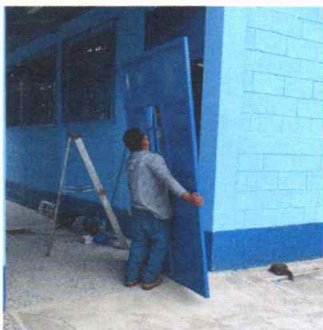
Foto1: Instalando puertas de aulas
