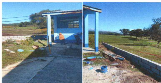
Foto 6: Realizando muro perimetral
