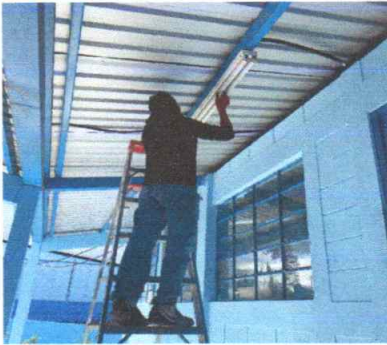
Foto1: Instalando candelas de lámparas
