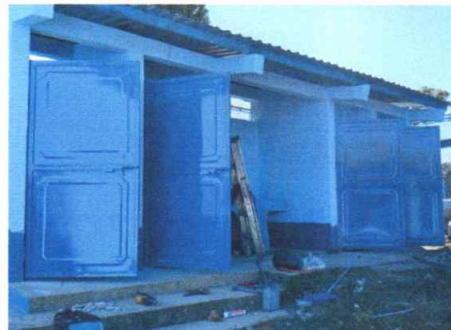
Foto 2: Instalando puertas de sanitarios
