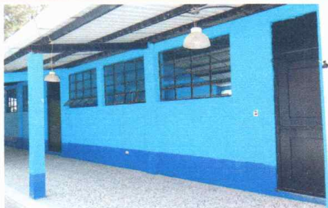
Foto 1: Puertas en aulas instaladas
