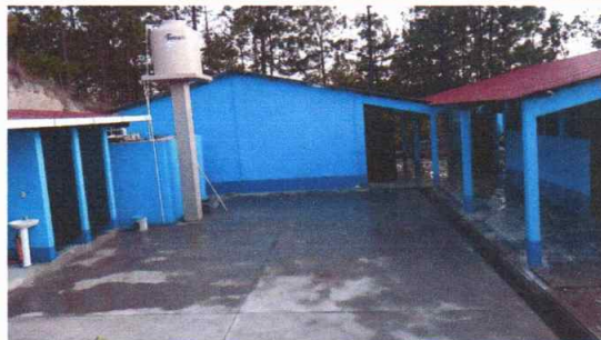
Foto 4: Base de concreto para depósito de agua realizada
