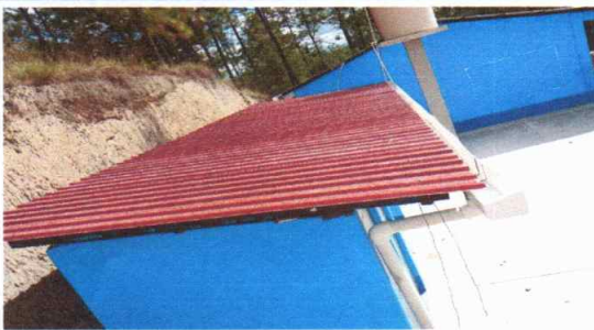
Foto 5: Cubierta de lámina instalada
