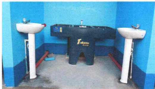
Foto 3: Pila instalada
