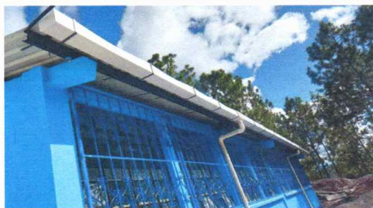
Foto 2: Balcones en ventanales instalados
