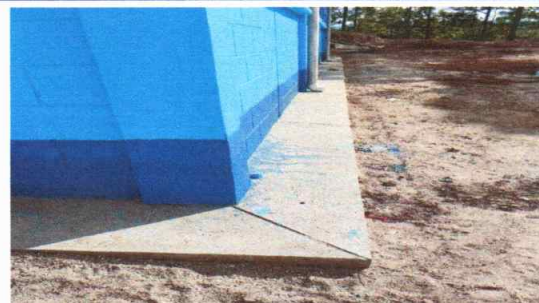
Foto 4: Banqueta de concreto realizada
