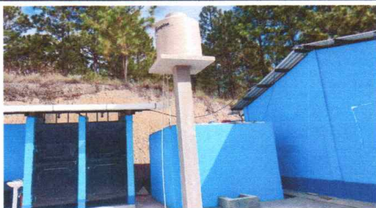
Foto 3: Canales de PVC instalados
