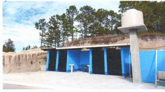
Foto 6: Lavamanos instalados en sanitarios
