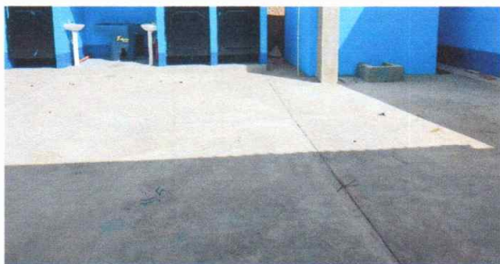
Foto 1: Plancha de concreto realizada
