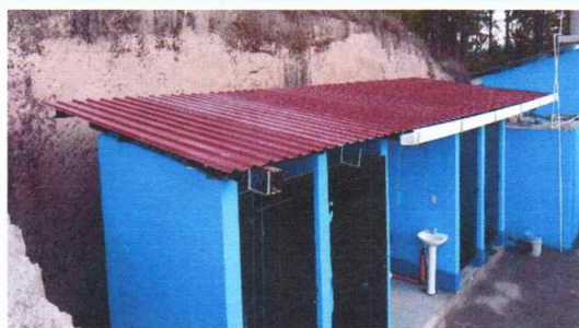
Foto 5: Instalando cubierta de lámina
