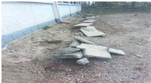
Foto 4: Realizando banqueta de concreto
