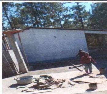
Foto 4: Realizando base de concreto para depósito de agua
