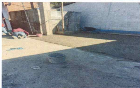
Foto 1: Realizando plancha de concreto
