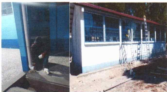
Foto 3: instalando canales de PVC
