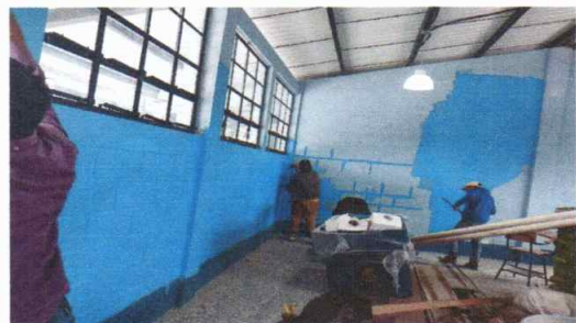
Foto 5: Aplicación de pintura del centro educativo
