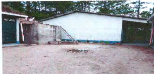
Foto 4: Mejoramiento a base de concreto para depósito de agua
