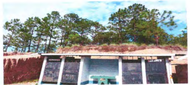
Foto 6: Pila inadecuada se necesitan lavamanos
