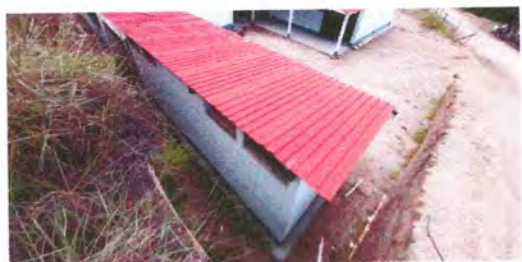
Foto 5: Cubierta de lámina en mal estado y es utilizada para captación de agua de lluvias
