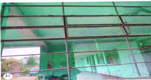
Foto 3: Estructura de metal de ventanas en mal estado
