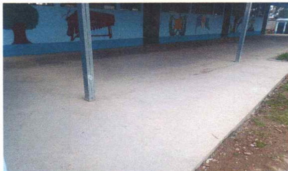
Foto1: Losa de patio finalizada
