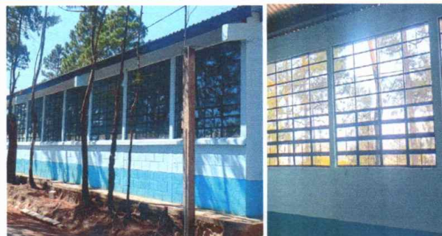
Foto 4: Ventanales con mantenimiento aplicado y vidrios instalados
