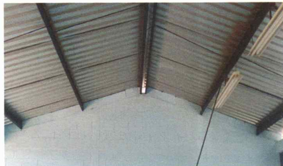
Foto 2: Estructura de soporte con mantenimiento aplicado
