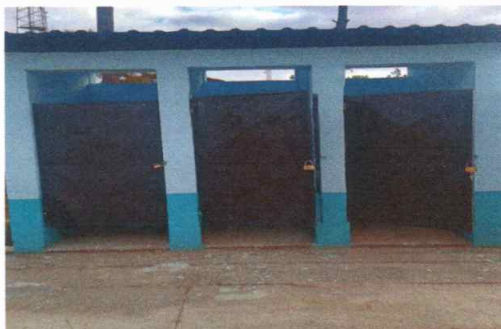
Foto 3: Puertas de sanitarios instaladas
