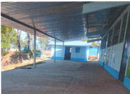
Foto1: Cubierta de lámina instalada
