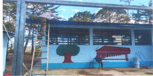
Foto 2: Realizando y colocando mantenimiento a estructura de soporte
