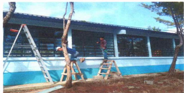
Foto 4: Dando mantenimiento a ventanales e instalando vidrios
