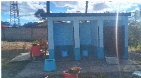
Foto 3: Instalando puertas de sanitarios
