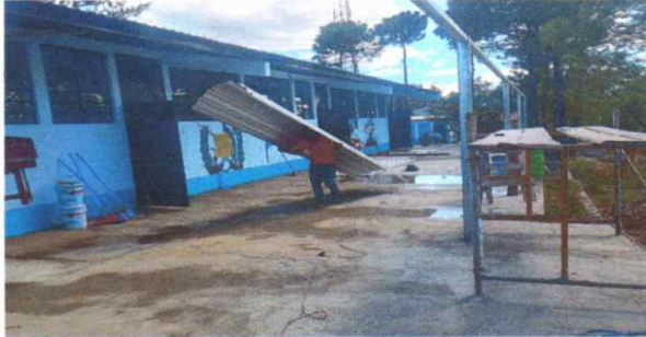
Foto1: Instalando cubierta de lámina
