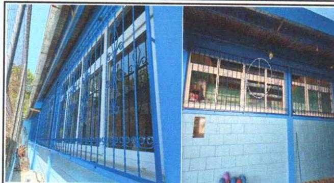
Foto1: Ventanas de PVC corredizas para tener una mejor ventilación y balcones de metal instalados
