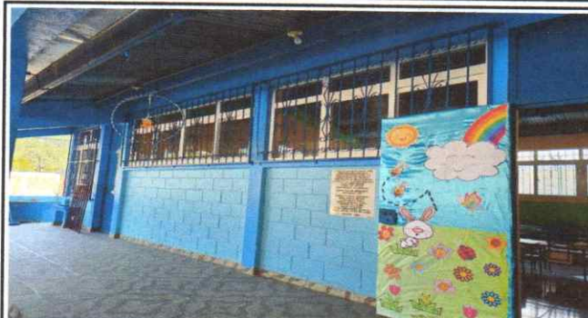
Foto 2: Ventanas de PVC corredizas para tener una mejor ventilación y balcones de metal instalados
