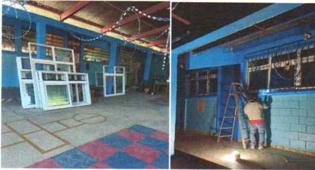
Foto1: Instalando ventanas de PVC corredizas para tener una mejor ventilación y balcones de metal
