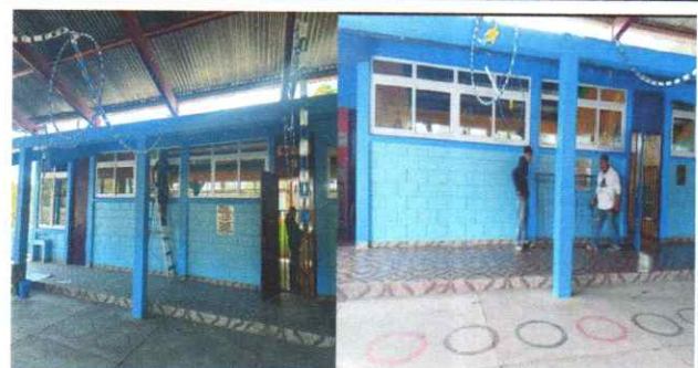
Foto 2: Instalando ventanas de PVC corredizas para tener una mejor ventilación y balcones de metal
