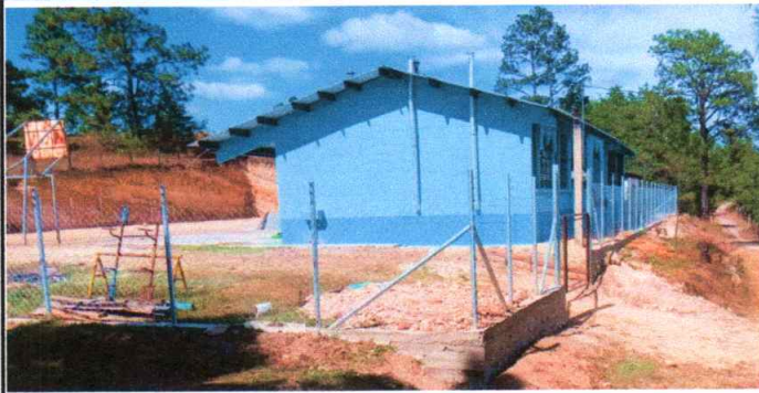
Foto1: Pintura de exteriores aplicada
