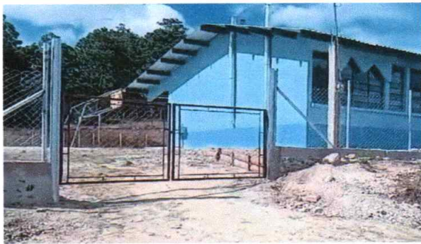
Foto 3: Portón de tubo y malla instalado
