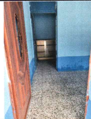
Foto 4: Piso granito en Dirección instalado
