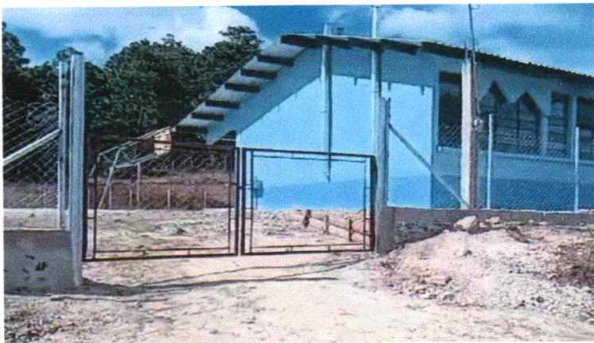
Foto 3: Portón de tubo y malla instalado
