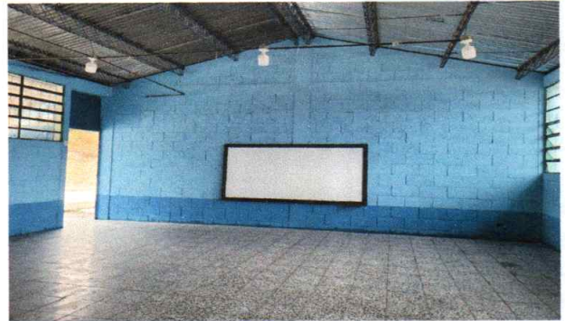
Foto 2: Piso de granito en aulas instalado
