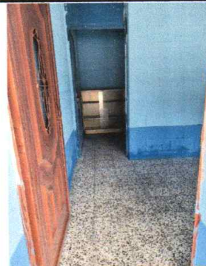
Foto 4: Piso granito en Dirección instalado
