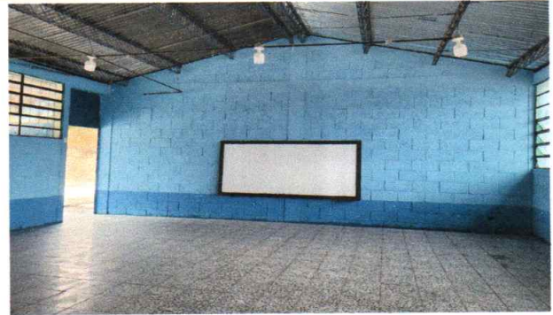
Foto 2: Piso de granito en aulas instalado
