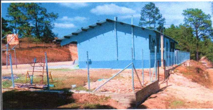
Foto1: Pintura de exteriores aplicada
