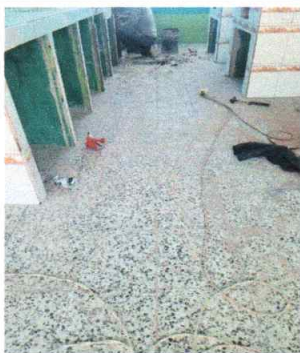
Foto 5: Colocación de piso granito en cocina
