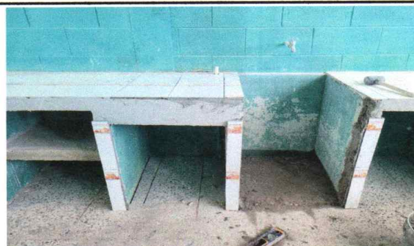
Foto 4: Cambio de pila artesanal por pila de concreto
