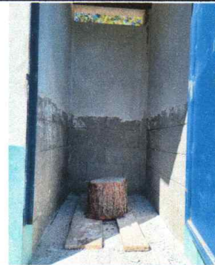
Foto 2: Mejoramiento de servicios sanitario
