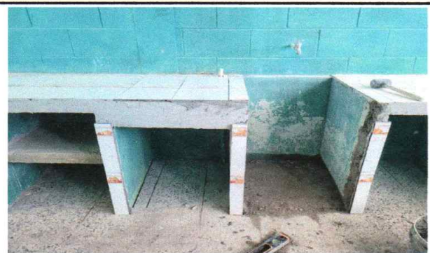
Foto 4: Cambio de pila artesanal por pila de concreto
