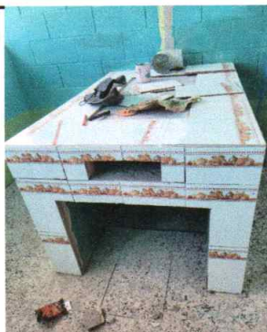
Foto 3: Cambio de planchas y chimeneas y colocación de azulejo
