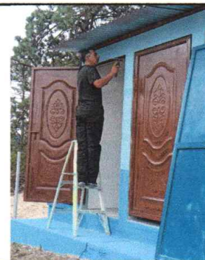
Foto 6: Instalación de puertas en sanitario
