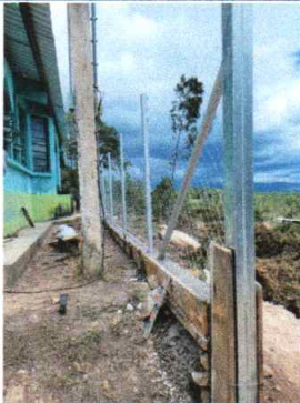
Foto 1: Mejoramiento de Cerco perimetral
