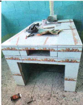
Foto 3: Cambio de planchas y chimeneas y colocación de azulejo
