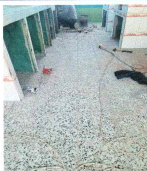
Foto 5: Colocación de piso granito en cocina
