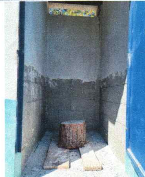
Foto 2: Mejoramiento de servicios sanitario
