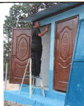
Foto 6: Instalación de puertas en sanitario
