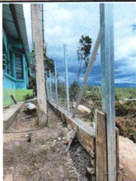
Foto 1: Mejoramiento de Cerco perimetral
