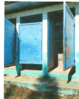
Foto 6: puertas de sanitarios en malas condiciones.
