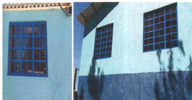
Foto 4: Ventanas instaladas y aplicación de pintura
