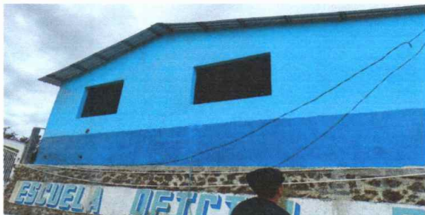
Foto1: Cubierta de lámina instalada
