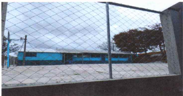
Foto 1: Malla de muro perimetral instalada
