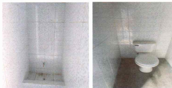
Foto 5: Azulejo en paredes de baño instalado
