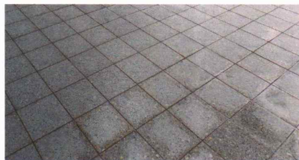
Foto 4: Piso granito instalado
