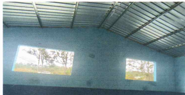
Foto 2: Estructura de techo instalada
