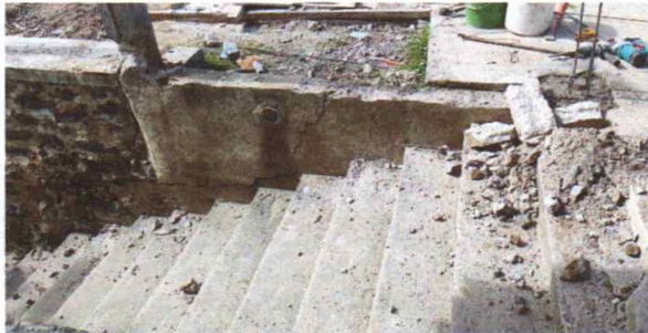
Foto 3: Reparación de muro
