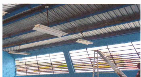
Foto 6: Instalación de lamparas led
