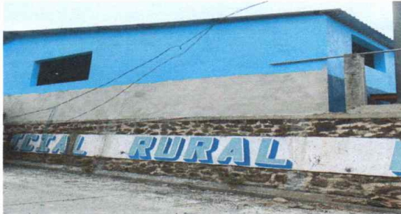
Foto1: Instalación de cubierta de lámina
