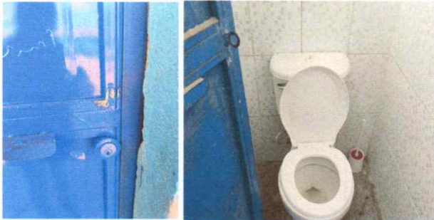
Foto 3: Instalación de Puertas e instalación sanitarios
