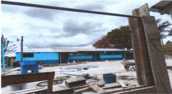
Foto 1: Reparación de muro perimetral cambió de malla
