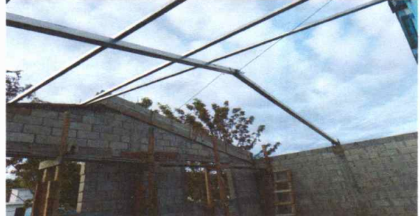
Foto 2: Instalación de estructura de techo
