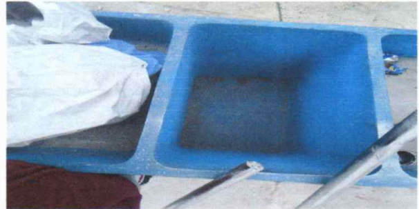
Foto 2: Colocación de pila nueva
