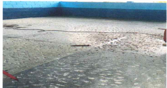
Foto 4: Instalación de piso granito
