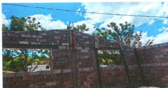
Foto 2: Mejoramiento a estructura de techo
