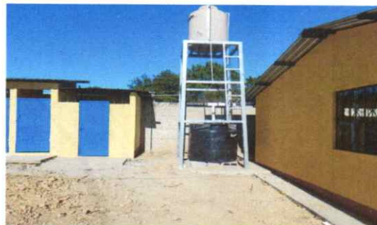
Foto 2: Depósitos de agua instalados, base de rotoplas terminada y fosa séptica concluida
