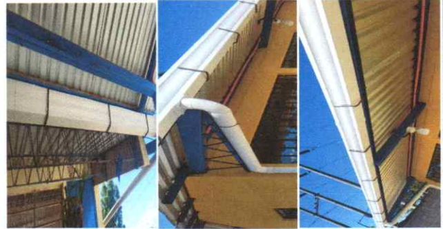
Foto 2: Canales instalados
