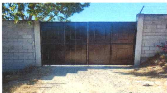
Foto 5: Portón de metal instalado
