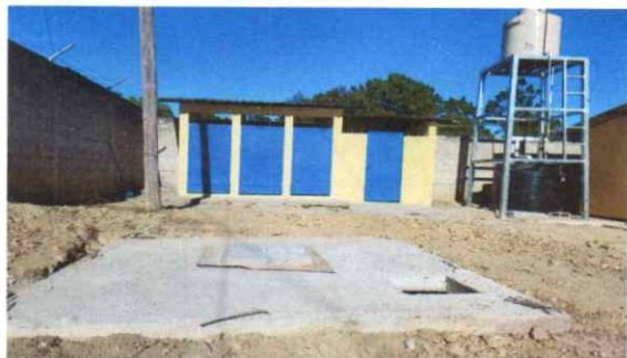
Foto1: Depósitos de agua instalados, base de rotoplas terminada y fosa séptica concluida
