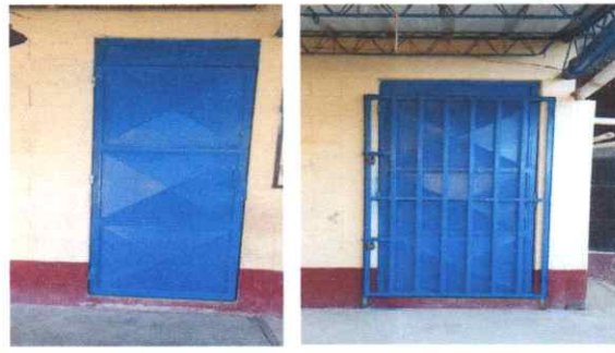
Foto 2: Puertas de aulas reparadas
