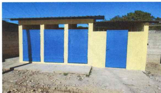
Foto 3: Puertas de sanitarios reparadas
