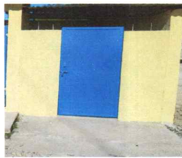
Foto 4: Puerta de migitorio instalada
