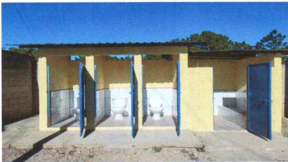
Foto 3: Sanitarios instalados y azulejo intalado a paredes
