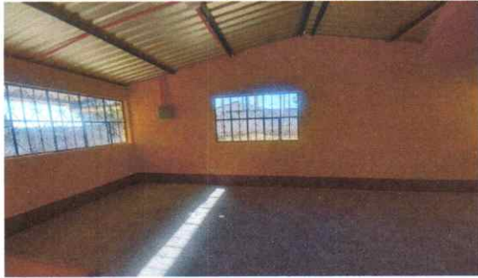
Foto1: Piso instalado en aula
