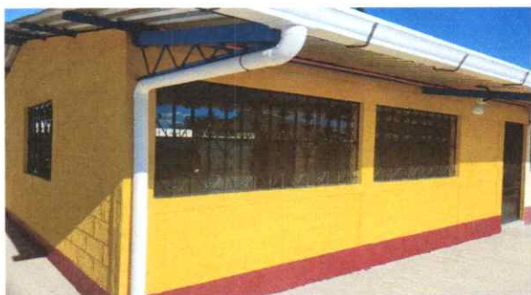
Foto1: Puerta en aula instalada
