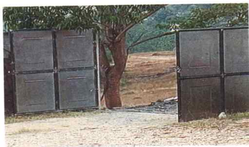
Foto 5: Instalando portón de metal
