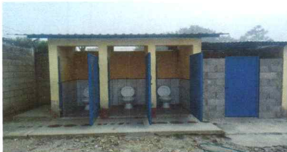
Foto 3: Colocando Sanitarios deteriorados y colocando azulejo a paredes dañadas necesitan protección
