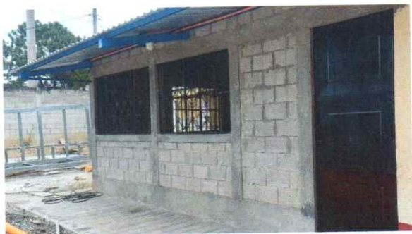
Foto 1: Instalado puerta en aula
