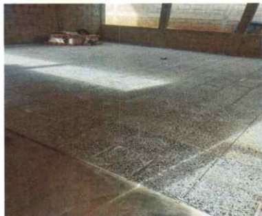
Foto1: Colocando piso en el aula de piso en aula
