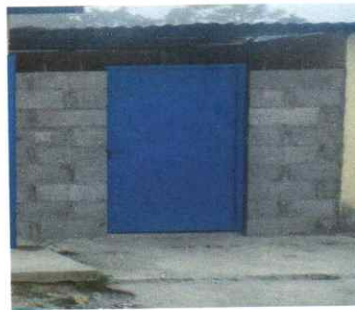
Foto 4: Instalando puerta de migitorio
