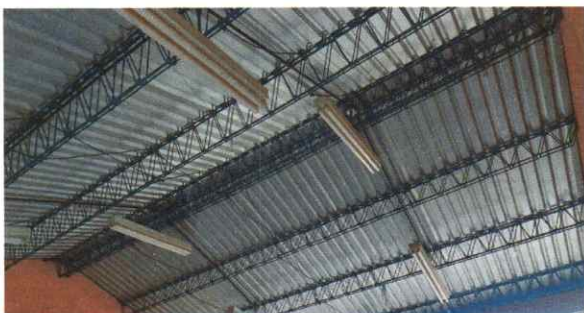
Foto 5: Instalando sistema eléctrico de todo el centro educativo deteriorado, lámparas no funcionan
