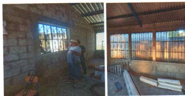
Foto 6: Instalando ventanas en aula
