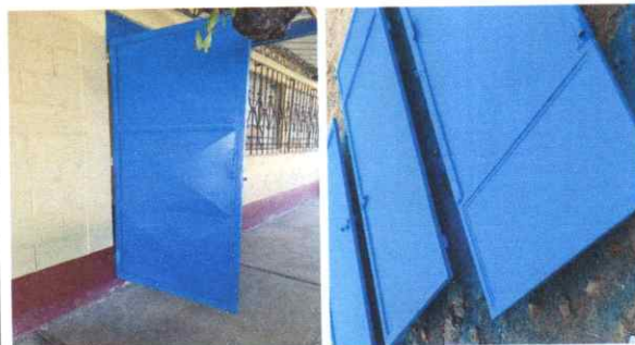
Foto 2: Dando mantenimiento a puertas de aulas
