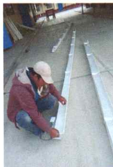
Foto 2: Colocando canales
