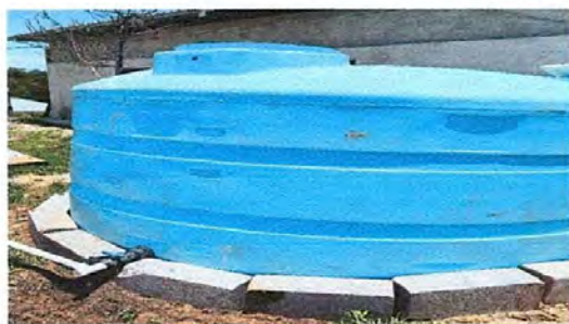
Foto 5: Depósito de agua nuevo e instalado
