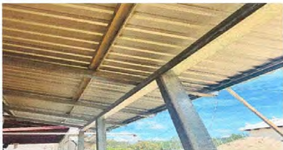
Foto 1: Lámina nueva e instalada
