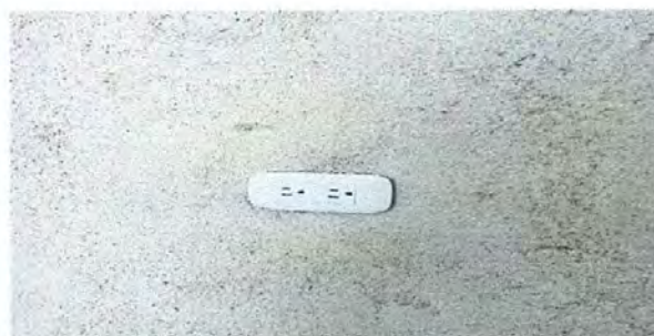
Foto 4: Sistema eléctrico nuevo e instalado
