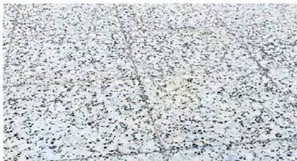
Foto 3: Piso nuevo instalado
