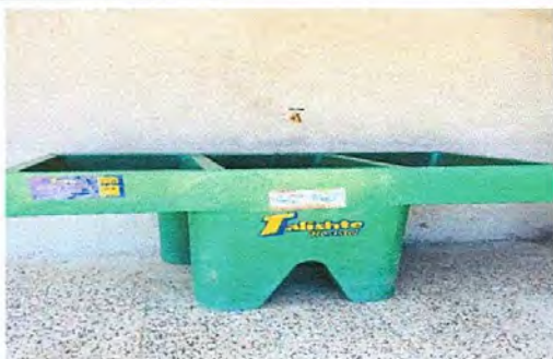
Foto 7: Pila nueva e instalada
