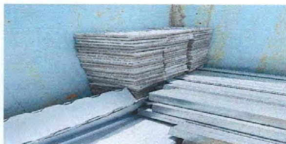
Foto: Piso granito para colocar
