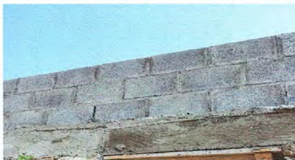
Foto 8: Relizando solera de terminación que se encontraba en mal estado
