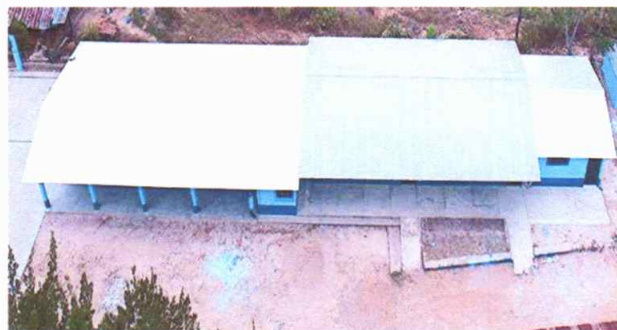
Foto1: Cubierta de lámina instalada
