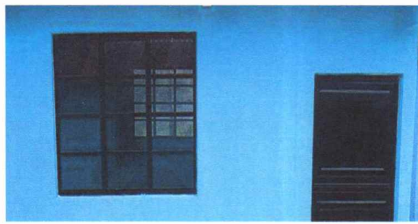
Foto 4: Ventanas en cocina instaladas
