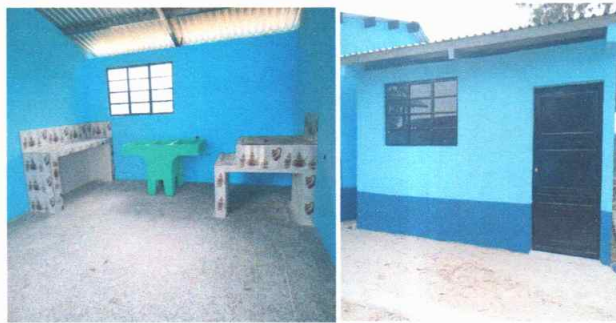
Foto 2: Culminados trabajos en cocina: de piso, repello en paredes, estufa rural, mueble de concreto y pila
