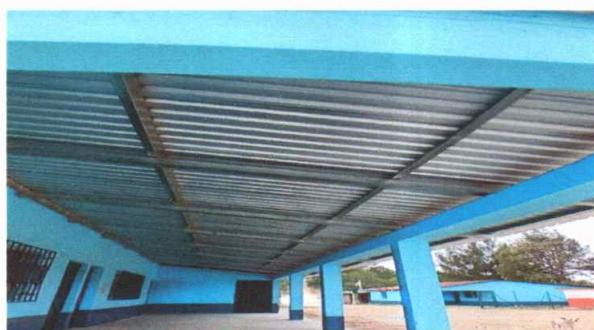
Foto 2: Estructura de soporte de metal galvanizado instalada
