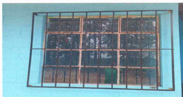
Foto 5: Instalando balcón y vidrios en ventana de dirección
