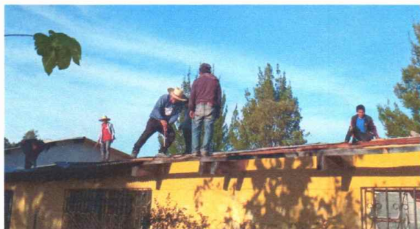
Foto1: Cambiando cubierta de lámina deteriorada
