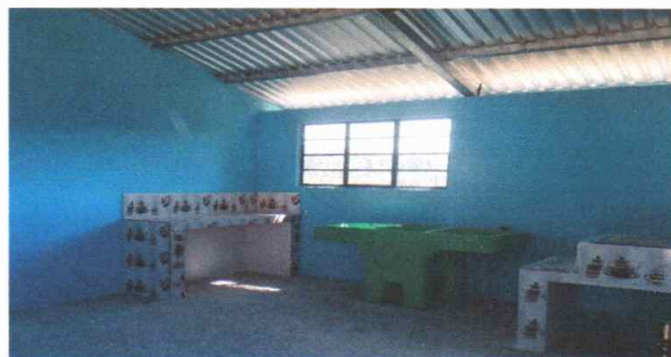
Foto 4: Instalando ventanas en cocina
