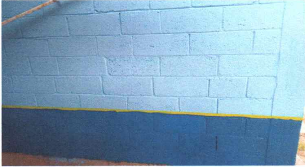
Foto1: Aplicación de pintura de todo el centro educativo
