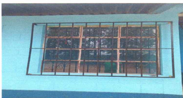
Foto 5: Instalando balcón y vidrios en ventana de dirección
