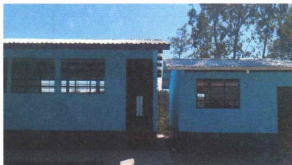
Foto 3: Instalando puertas en aula y en cocina
