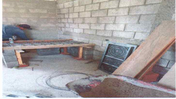
Foto 2: Realizando trabajos en cocina de piso, repello en paredes, esturfa rural, mueble de concreto y pila
