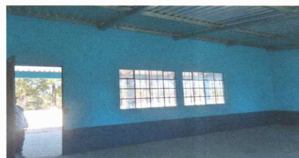
Foto 6: Realizando lijado y aplicación de pintura en balcones de aulas
