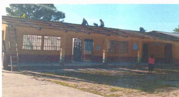
Foto 2: Cambiando estructura de soporte de madera por metal galvanizado
