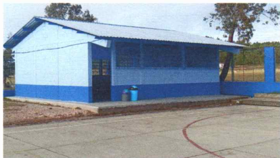
Foto1: Cubierta de lámina instalada
