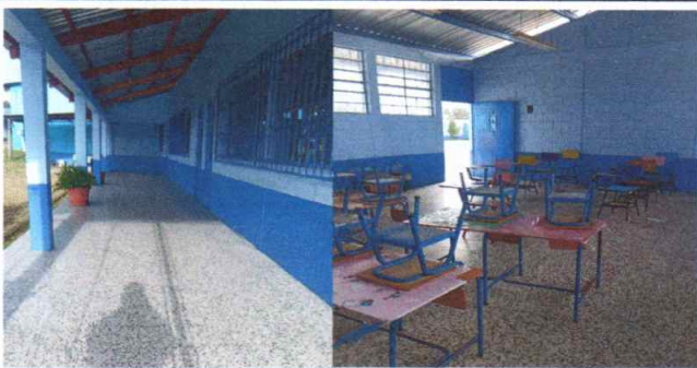
Foto 5: Piso de granito instalado
