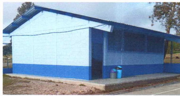
Foto 2: Estructura de soporte con mantenimiento aplicado
