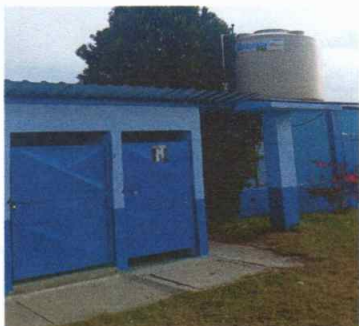
Foto 3: Depósito de agua instalado
