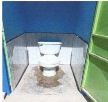
Foto 2: Azulejo instalado en sanitarios para protección de paredes
