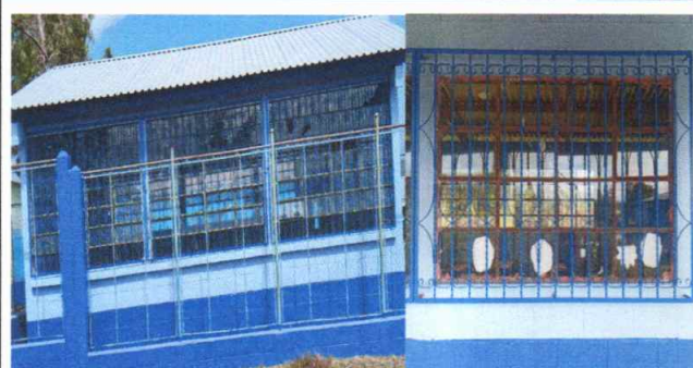
Foto 4: Ventanales con balcones instalados y estructuras de balcones con mantenimiento aplicado
