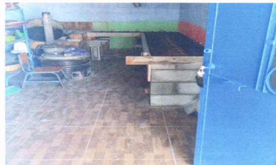
Foto 4: Realizando mueble de cocina
