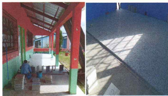
Foto 5: Instalando piso granito
