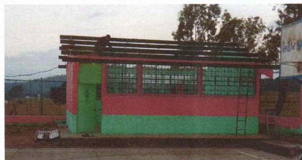
Foto 2: Aplicando mantenimiento a estructura de soporte
