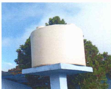
Foto 3: Instalando depósito de agua
