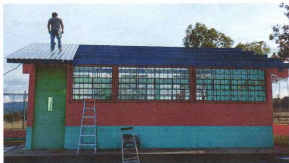
Foto1: Instalando cubierta de lámina
