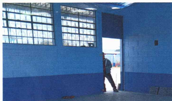
Foto 3: Aplicando mantenimiento a puertas
