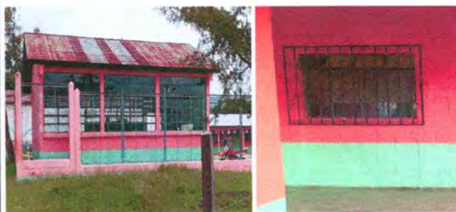
Foto 4: Ventanales expuestos sin balcones y estructuras de balcones en mal estado
