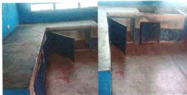
Foto 4: Muebles de cocina de concreto y pila concreto en malas condiciones falta azulejo
