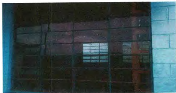
Foto 5: Ventanas expuestas quiebran vidrios a falta de balcones
