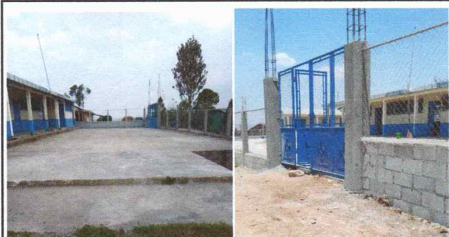
Foto1: Portón instalado en etrada principal
