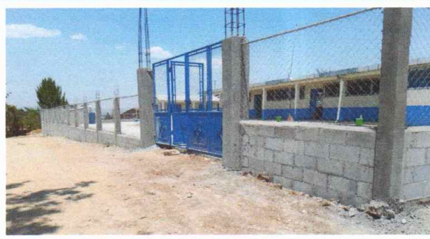
Foto 4: Muro perimentral culminado en todas las fases
