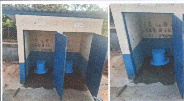
Foto 2: Tasas de inodoros instaladas
