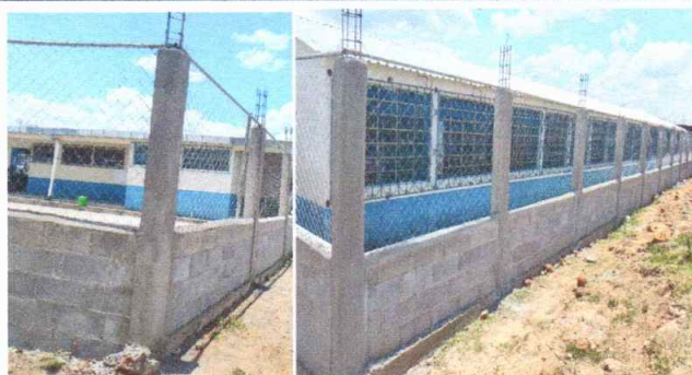
Foto 3: Muro perimentral culminado en todas las fases
