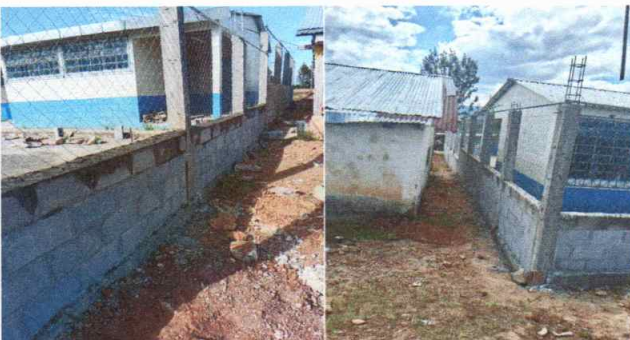
Foto 3: Realizando Muro perimetral en todo el centro educativo
