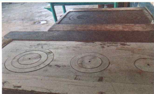
Foto 5: Instalando plancha de metal de tres hornillas
