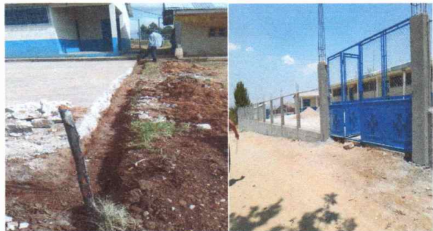
Foto1: Realizando bases e instalando portón en la entrada principal
