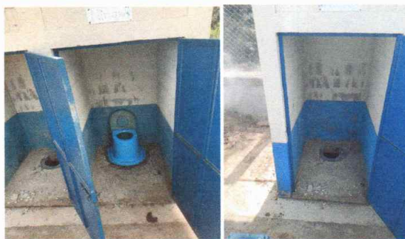
Foto 2: Instalando tasas de inodoros
