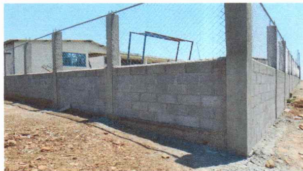
Foto 4: Realizando Muro perimetral en todo el centro educativo
