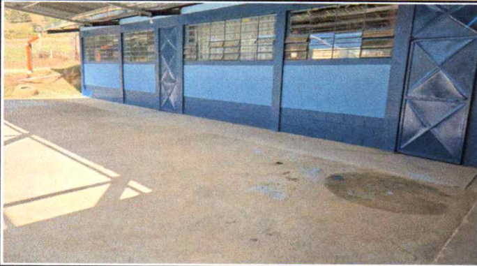
Foto 7: Torta de concreto terminado
