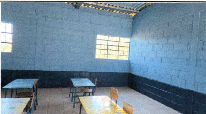
Foto 9: Pintura en muros interiores Aplicada
