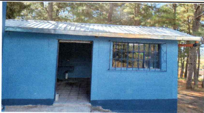
Foto1: Cubierta de lámina y estructura de techo Instalado
