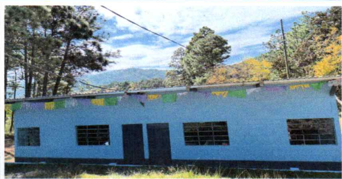
Foto 11: Pintura en muros exteriores Aplicada
