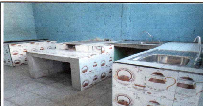
Foto 6 : Plancha de metal Instaladas
