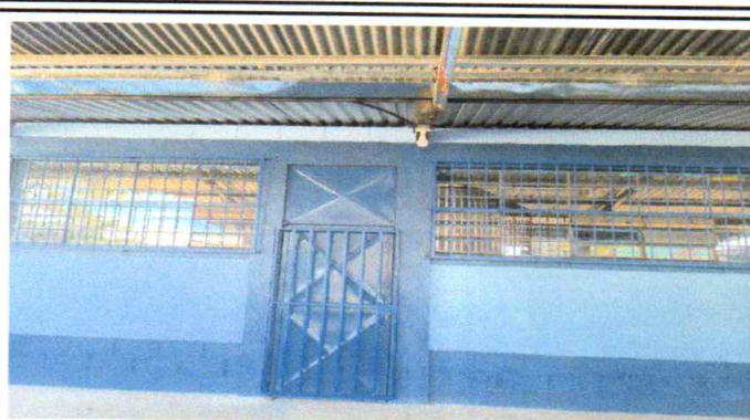
Foto 2: Puertas y balcones instalados
