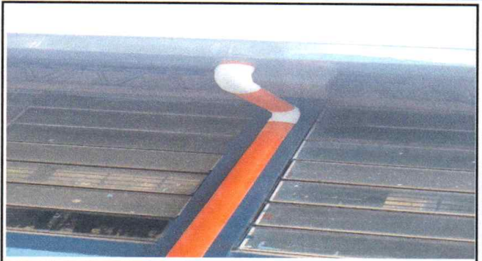
Foto 8: Bajadas de agua pluvial instaladas
