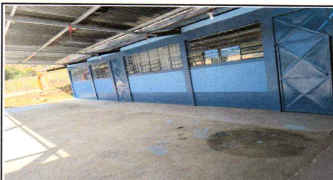
Foto 4: Canal de metal instalado
