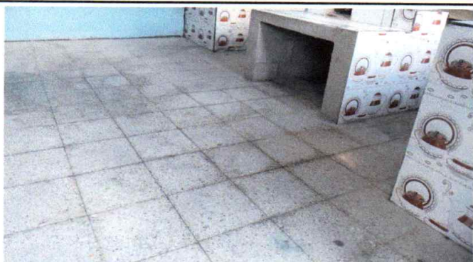
Foto 3: Piso granito Instalado
