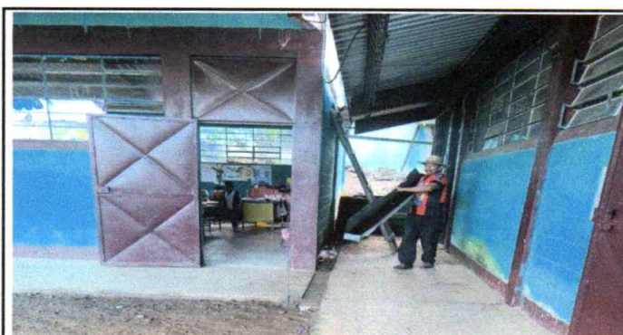
Foto 4: Instalando canal de metal
