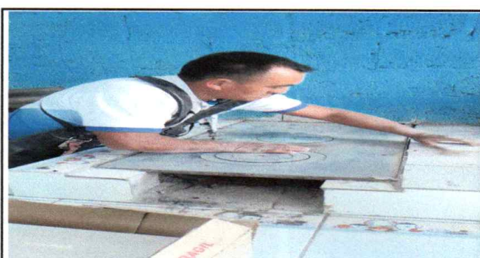
Foto 6: Instalando plancha de metal
