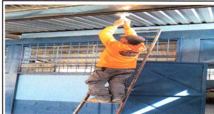
Foto 10: Instalando el Sistema eléctrico
