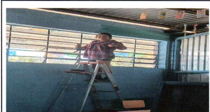
Foto 9: Aplicando Pintura en muros interiores
