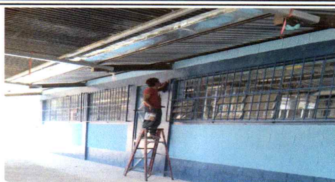
Foto 2: Instalando puertas y balcones
