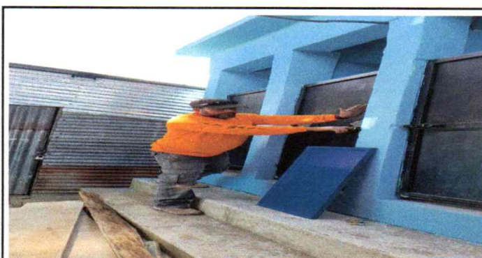
Foto 5: Instalando Mantenimiento de puertas y tapaderas de abonera en baño
