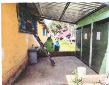
Foto 5: Piso de concreto en baños en mal estado
