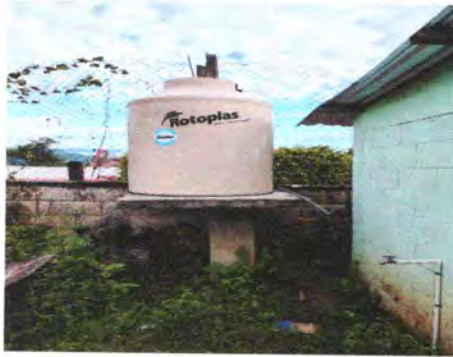
Foto 7: Abastecimiento de agua deficiente
