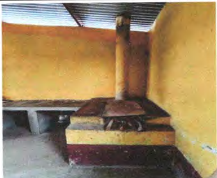
Foto 1: Plancha en mal estado
