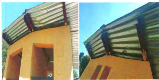
Foto1: Cubierta de lámina y estructura de soporte detereorada en baños
