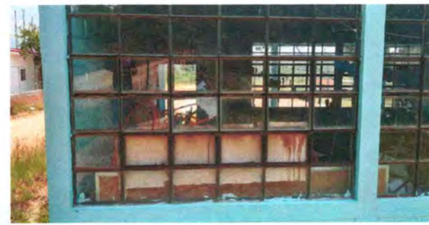
Foto 4: Estructura de ventanas de metal en mal estado y vidrios quebrados
