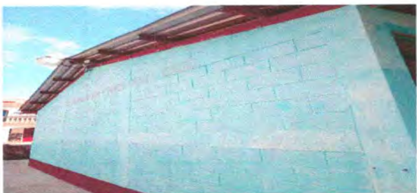
Foto 5: Pintura deteriorada
