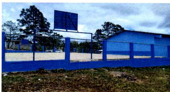
Foto 5: Muro perimetral en buen estado
