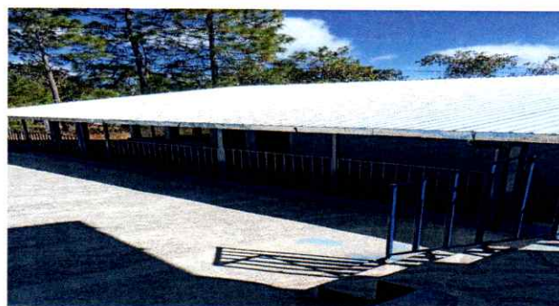
Foto 4: Barandas terminadas y completas
