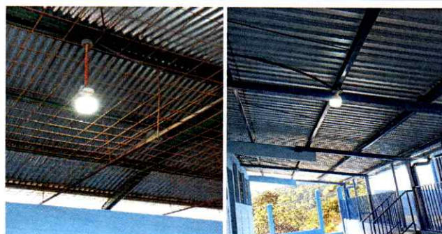
Foto 6: Focos LED nuevos instalados
