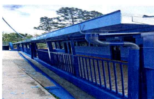
Foto 2: Canal resistente e instalado
