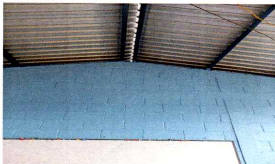
Foto1: Lámina en buen estado
