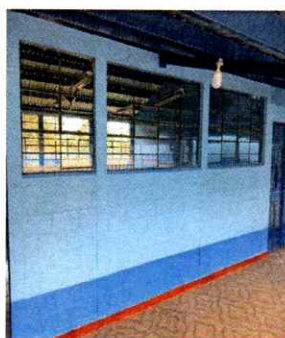
Foto 3: Aplicación de pintura culminada
