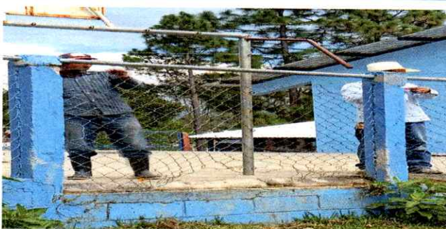
Foto 5: Reparando muro perimetral
