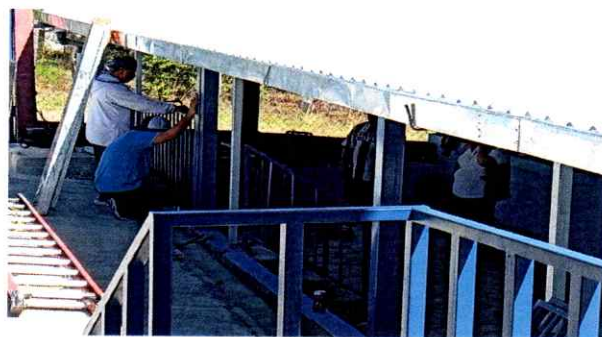
Foto 4: Barandas en proceso de instalación
