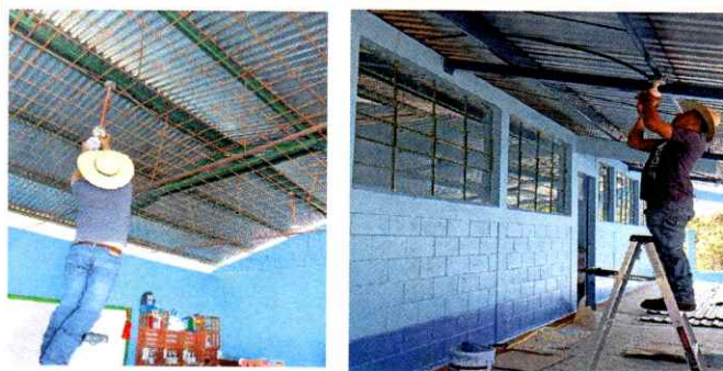
Foto 6: Focos LED en proceso de instalación
