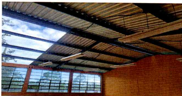
Foto1: Lámina en proceso de cambio
