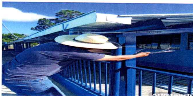
Foto 2: Puesta de canal y bajadas de agua
