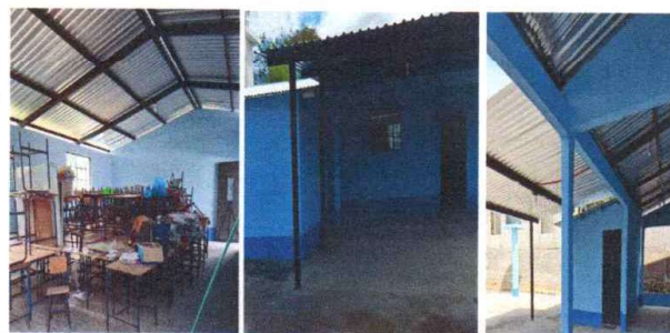
Foto 2: Estructura de techo con aplicación de mantenimiento
