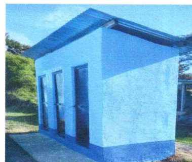
Foto 4: Puertas de servicios sanitarios instaladas
