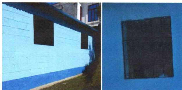
Foto 5: Ventanas con aplicación de mantenimiento y vidrios instalados
