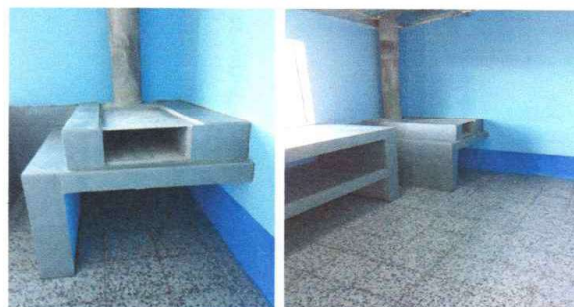
Foto 6: Paredes de cocina repelladas y pintadas
