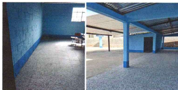
Foto 6: Piso granito instalado
