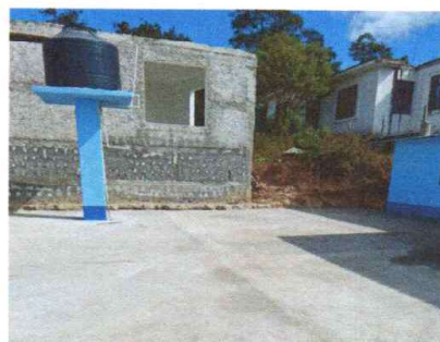
Foto 4: Depósito de agua con tapadera instalada y base de concreto reparada
