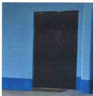
Foto 3: Puerta de aulas y cocina con mantenimiento aplicado
