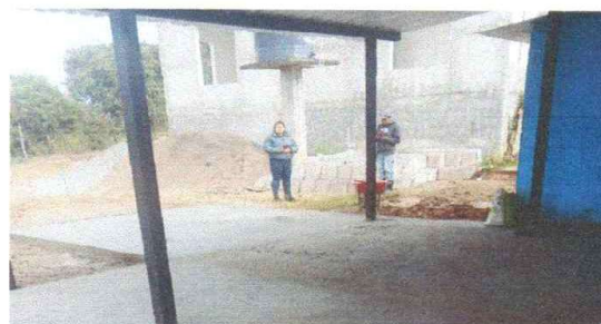
Foto 4: Instalando tapadera de depósito y trabajando base de concreto en mal estado
