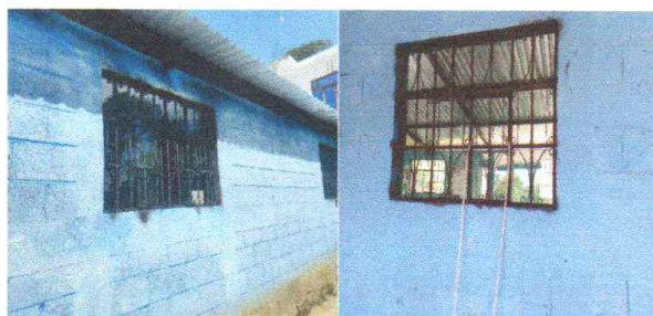
Foto 5: Realizando mantenimiento a ventanas y cambio de vidrios
