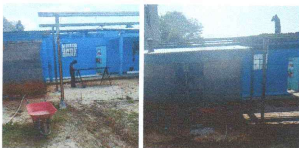
Foto1: Realizando cambio de cubierta de lámina
