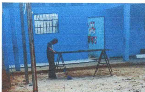
Foto 3: Realizando mantenimiento a puertas de aulas y cocina
