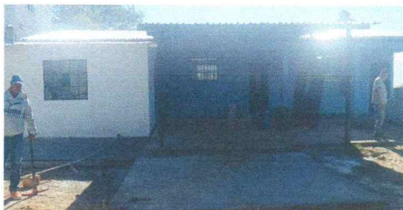
Foto 3: Realizando Losa de patio
