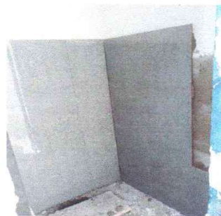
Foto 2: Colocando azulejo a paredes de sanitarios
