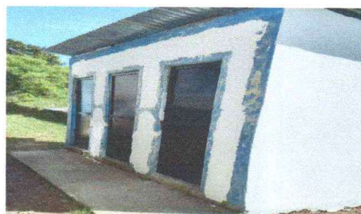
Foto 4: Realizando cambio de puertas de servicios sanitarios
