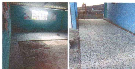
Foto 6: Realizando cambio de piso
