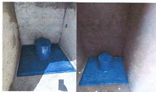
Foto 4: Sanitarios nuevos e instalados y terminados
