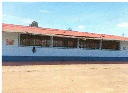
Foto 3: Aplicación de pintura terminada
