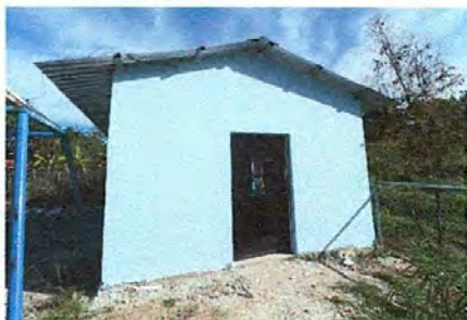
Foto1 1: Cubierta y estructura de soporte instalada y terminada
