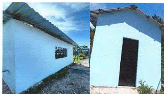
Foto 8: Mejoramiento pared cocina terminado
