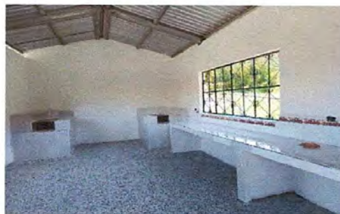
Foto 6: Estufas rurales instaladas y terminadas
