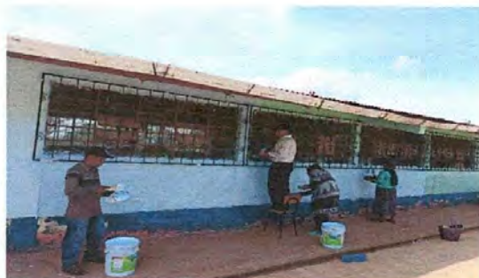
Foto 3: Proceso de aplicación de pintura
