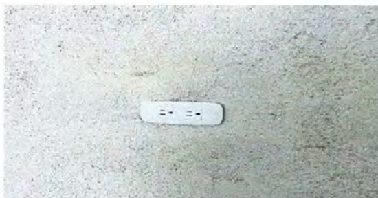
Foto 5: Sistema eléctrico en proceso de instalación
