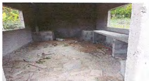
Foto 6: Estufas rurales en proceso de instalación
