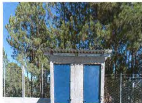
Foto 2: Estructura de techo instalada
