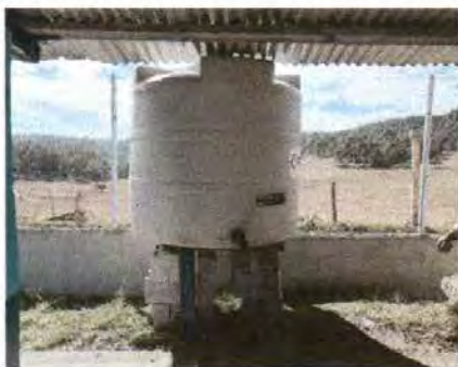
Foto 5: Depósito de agua instalado
