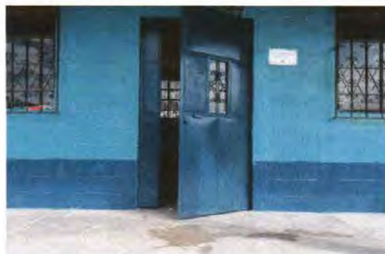
Foto 4: Puerta de aula instalada
