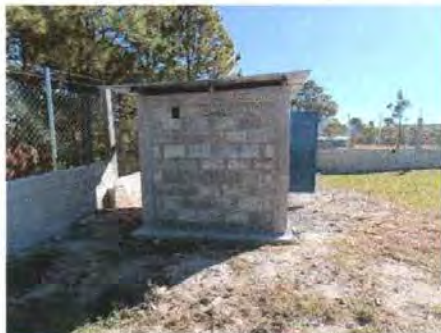
Foto 1: Cubierta de lámina instalada
