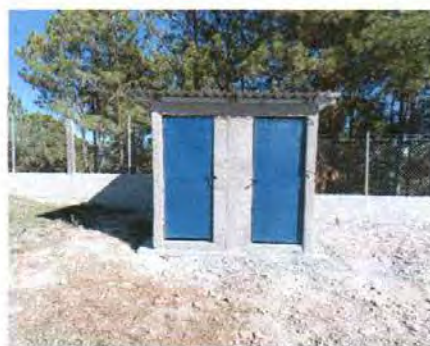
Foto 2: Puertas de los baños instaladas
