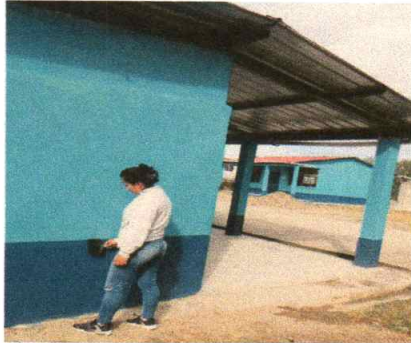
Foto 1: Aplicación de pintura
