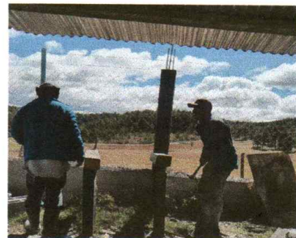
Foto 4: Realizando muro perimetral
