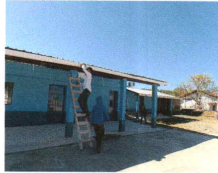
Foto 2: Cambio de canales
