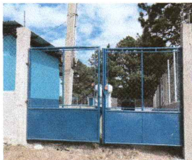
Foto 5: Cambio de portón
