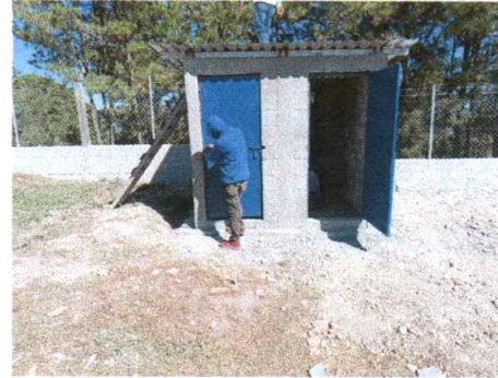
Foto 2: Cambio de estructura de techo
