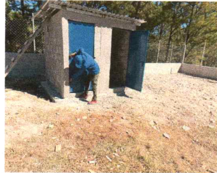
Foto 2: Instalando puertas de los baños
