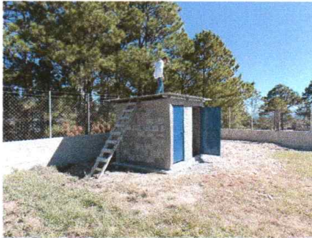
Foto1: Instalando cubierta de lámina
