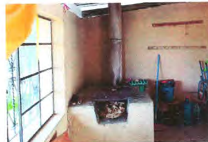
Foto 6: Estufa rural en mal estado
