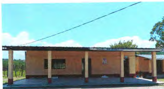
Foto 2: Los canales estan deteriorados
