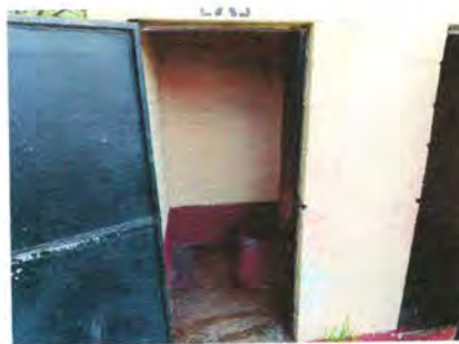
Foto 6: La torta de cemento en los sanitarios esta en mal estado
