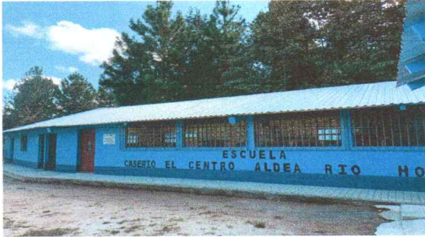
Foto1: Cubierta de lámina nueva instalada
