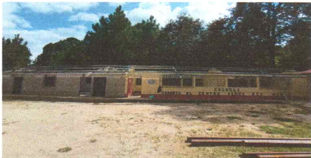
Foto1: Cubierta de lámina en proceso de instalación.
