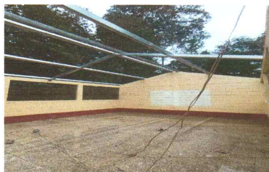
Foto 4: Estructura de techo en proceso de instalación.
