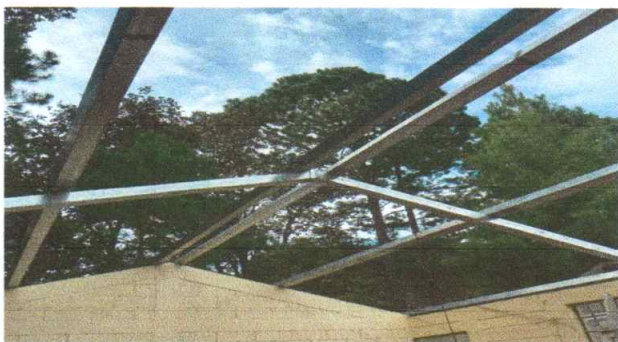
Foto 3: Estructura de techo en proceso de instalación.
