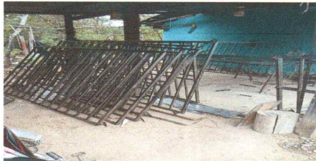
Foto 2: Mejoramiento a ventanas, que no tienen balcón, en proceso de fabricación.
